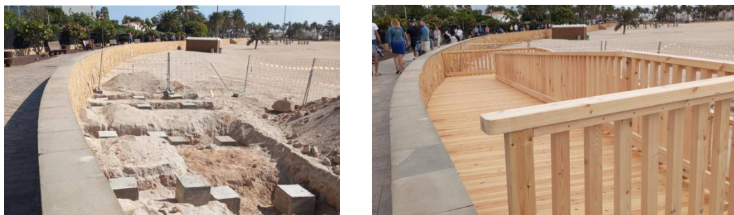
Figura 12. Antes y después de la instalación de la rampa de acceso a la playa principal.
